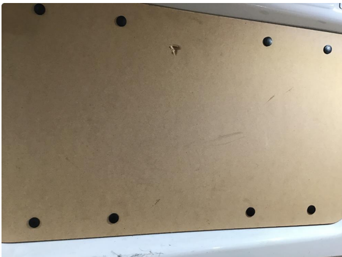
1.3 Liten skade på øvre deksel bak i lasterom.
