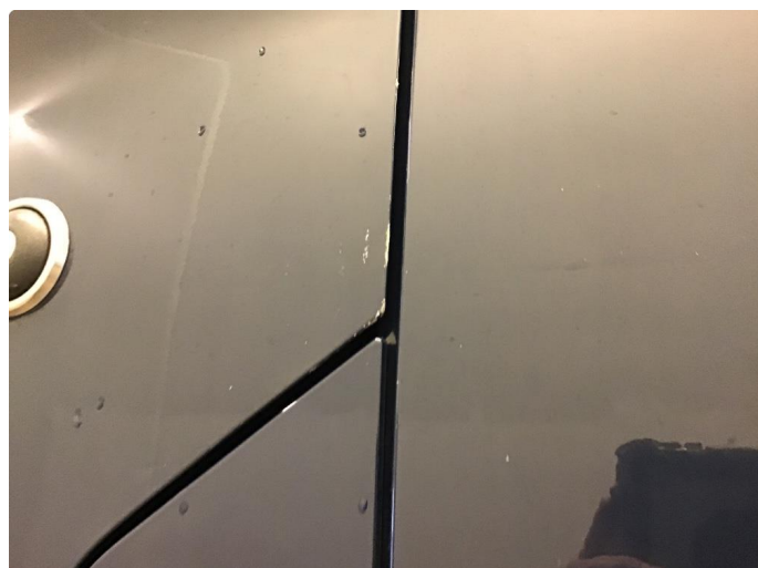
1.1 Slitt lakk, samt noe korrosjon
