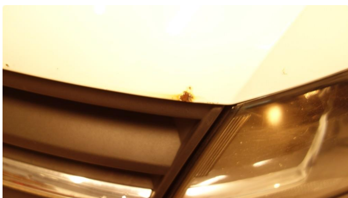
2.1 Rust i fals
