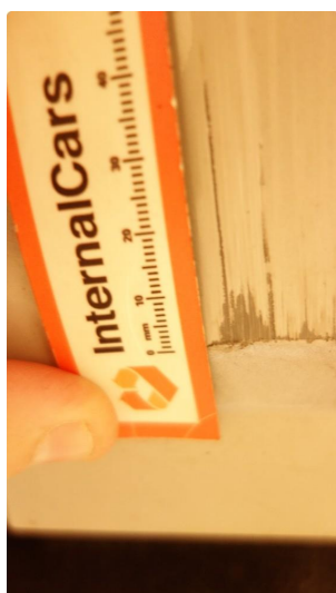
1.1 Skrubbskader underkant
