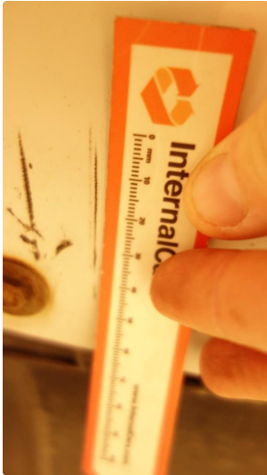
1.1 Skrubbskader underkant
