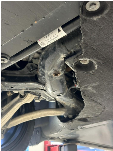
1.1 Liten skade i beskyttelsesplate under bil
