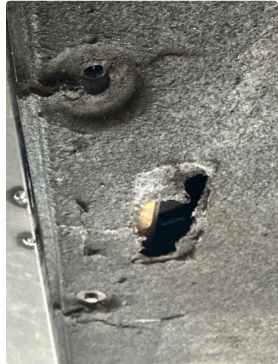
1.1 Noen hull i beskyttelsesplate under motor
