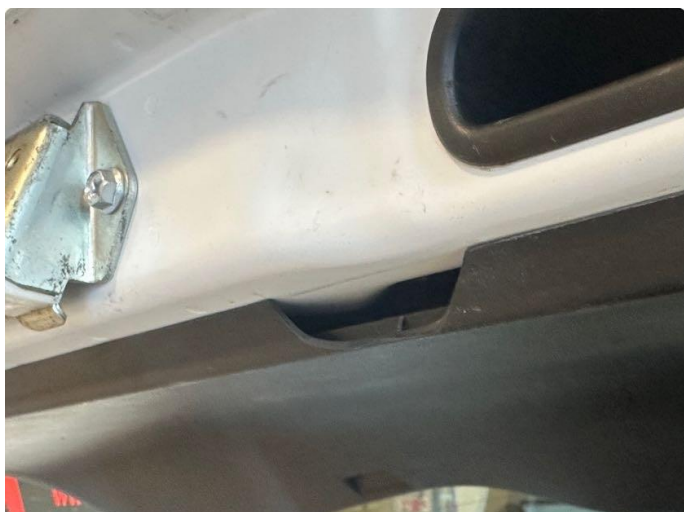
1.1 Liten skade i deksel på innside av bakluke
