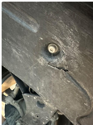
1.1 Ett par sprekker i beskyttelsesplate under motor. Ingen praktisk betydning
