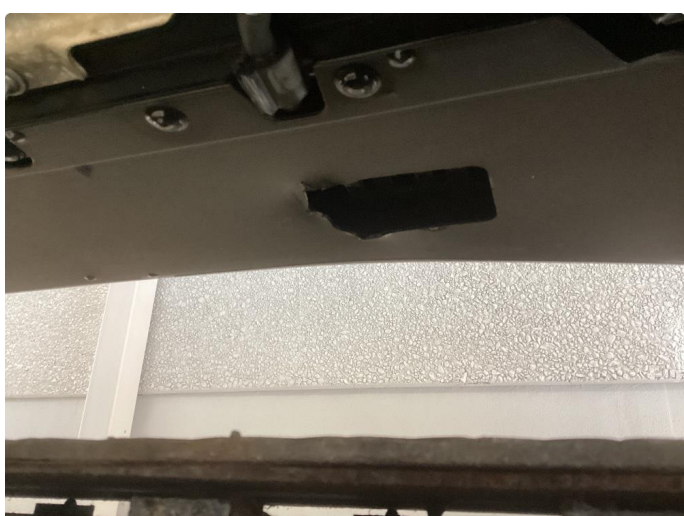
1.2 Mangler løfte paden høyre side bak
