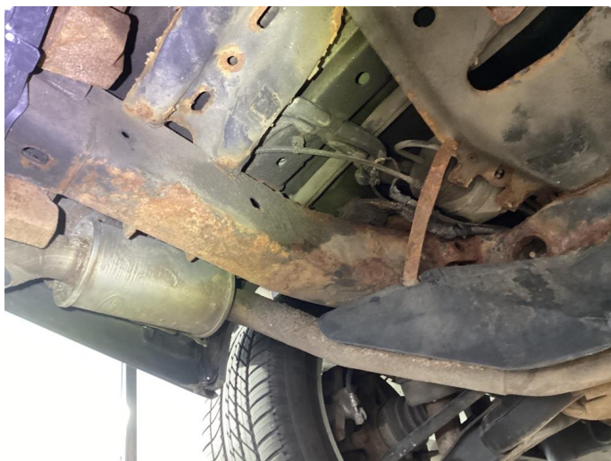
1.5 Rust under bil/ramme, er nok mest overflatisk
