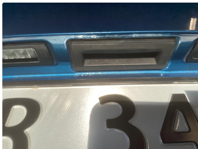
1.3 Noe påbegynnende rust bakluke
