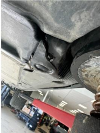
1.1 Liten sprekk i beskyttelsesplate under motor
