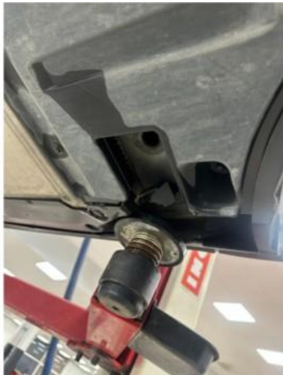
1.1 Små skader i beskyttelsesplate under bilen. Normal slitasje
