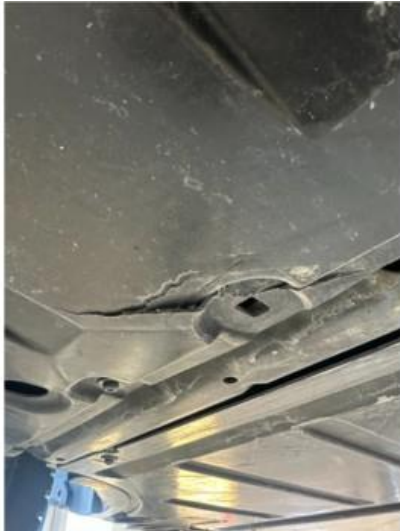
1.1 Liten sprekk i beskyttelses plate under motor
