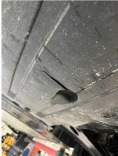
1.1 Noen sprekker i beskyttelsesplate under bilen
