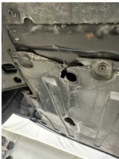
1.1 Noen små sprekker i beskyttelsesplate under bil. Normal slitasje
