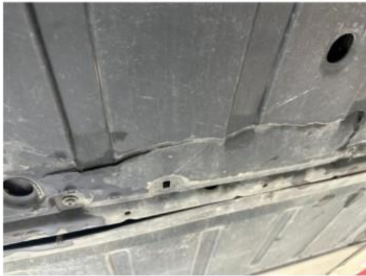
1.1 Liten sprekk i beskyttelsesplate under bil
