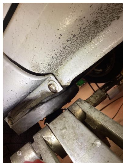
1.5 Noe slitasje/påbegynt korrodering
