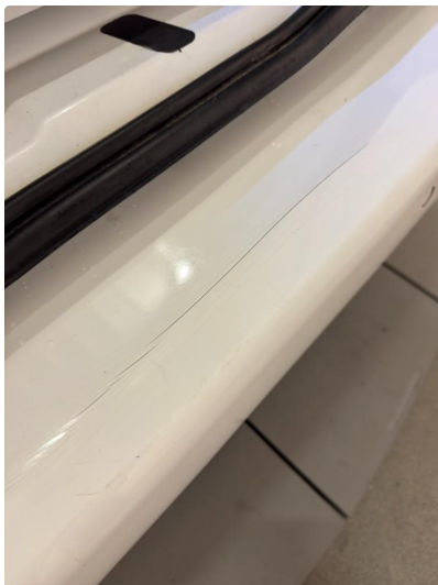
1.2 Sprekk i lakk
