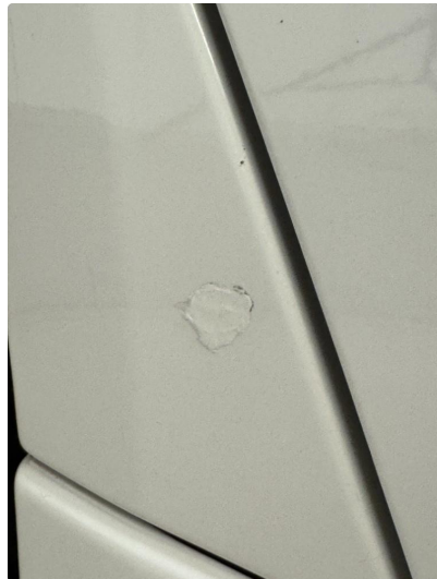
1.2 Steinsprang med rust
