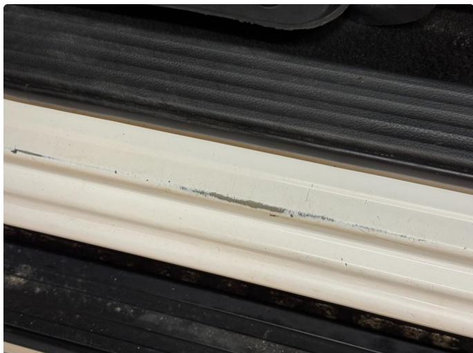
1.1 Slitasje på terskel
