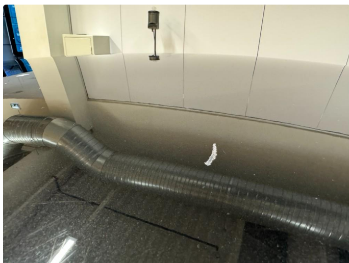
1.8 Ripe ned til grunning
