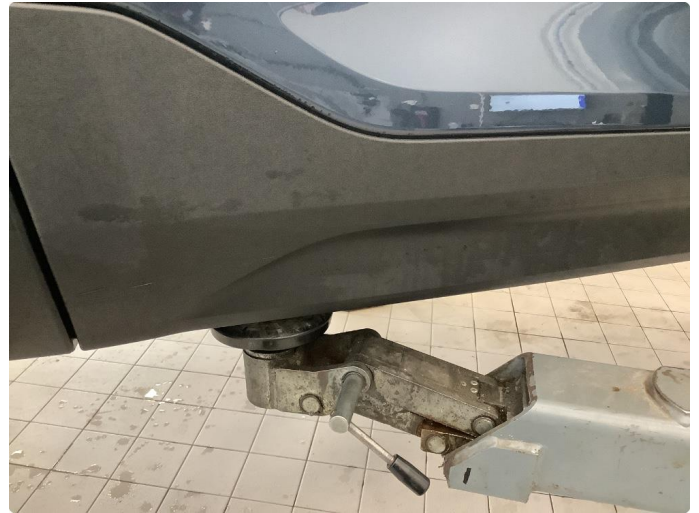
1.1 Noen merker på dørlister høyre side
