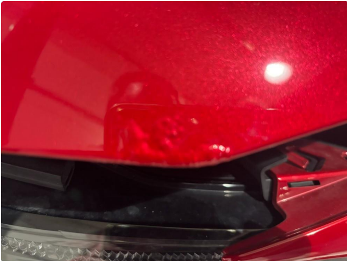
1.1 Noe korrosjon under lakk
