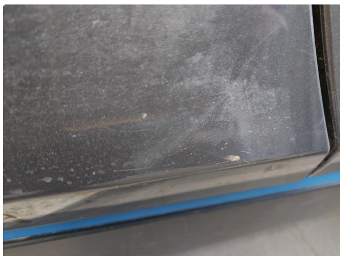
1.2 Riper - 11.05.26 EK - Utbedret med lakkrens
