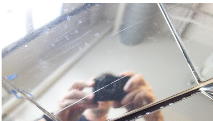
1.1 Generelt mye riper - 11.06.2026 EK - Utbedret med lakkrens
