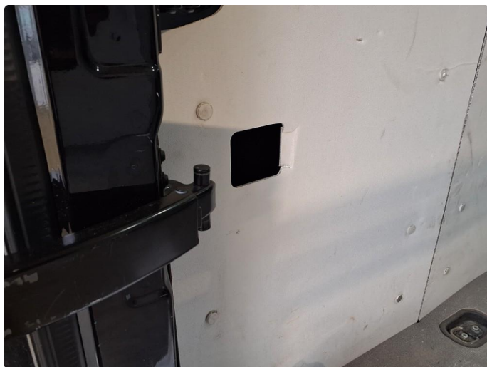
2.2 Deksler skadet/mangler
