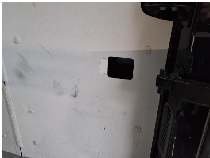
2.2 Deksler skadet/mangler
