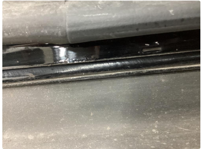
1.3 Rust i fals
