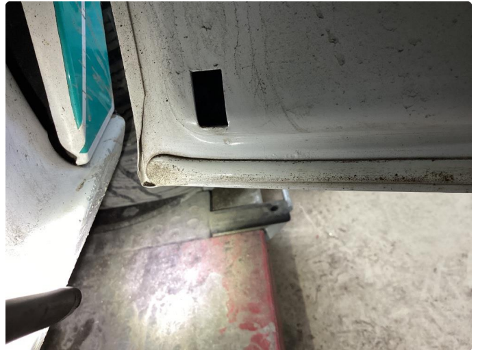
1.1 Rust i fals
