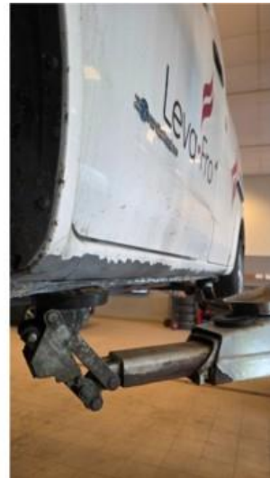
1.2 Lakkflass på kanaler
