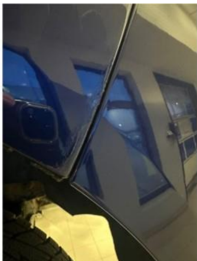
1.1 Litt antydning til rustdannelse på begge skjermer bak. Pusses og lakkeres forenklet.
