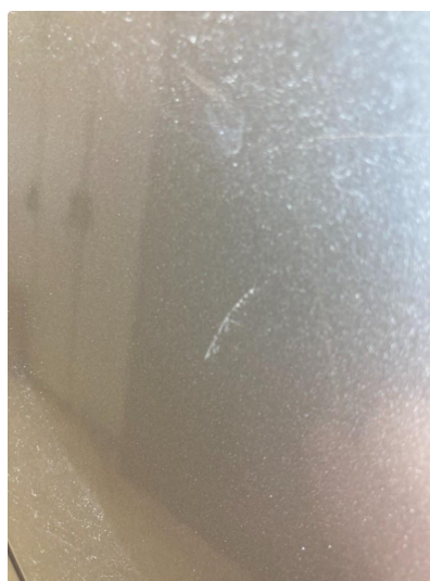
1.2 Ripe(r) ned til grunning. Skal utbedres.
