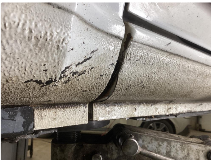
1.3 Noe bruksslitasje, normal iht. alder/km.
