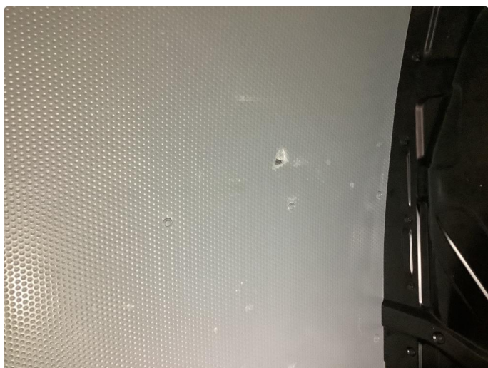
4.1 Deksler skadet/mangler
