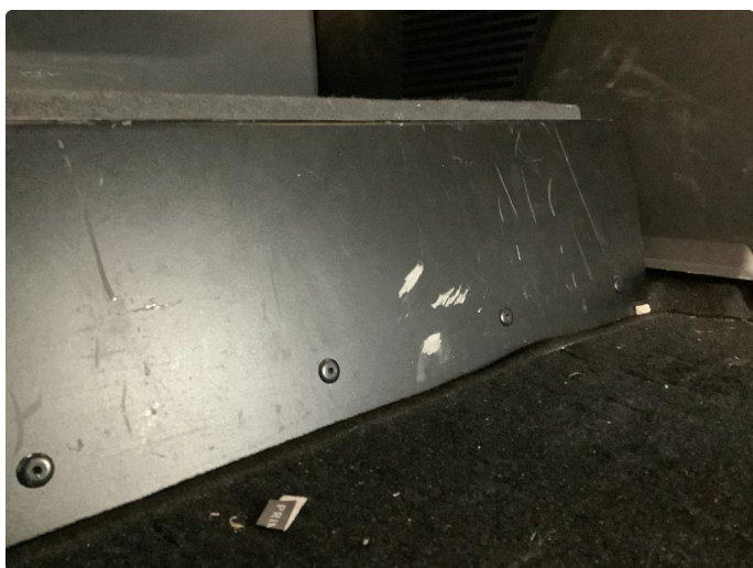
2.2 Deksler skadet/mangler
