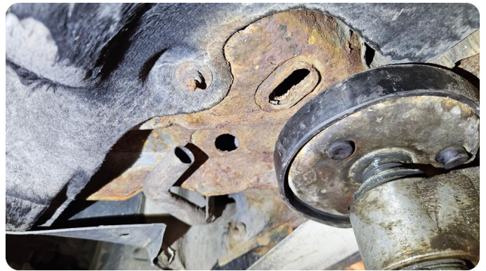
2.8 I kanaler Sterkt preget av korrosjon/rust i kanaler begge sider, delvis også gulv.
