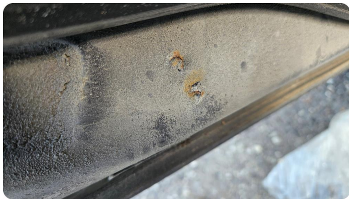
2.4 Rust/korrosjon Skade/rust i alle 4 dører
