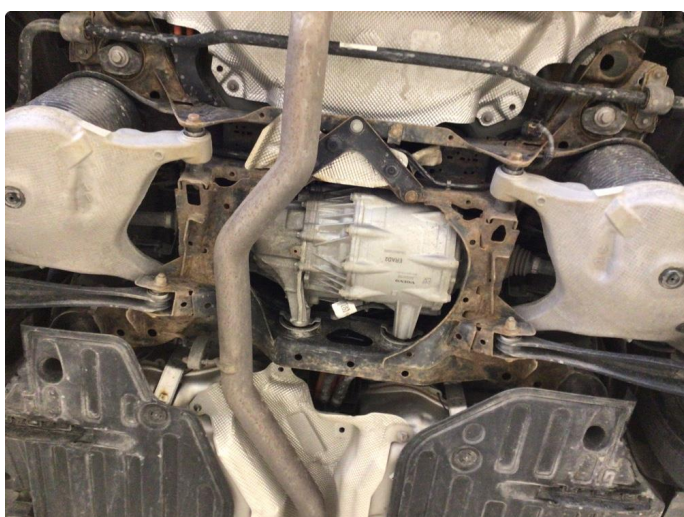
1.2 Overflaterust på travers foran og bak, normalt med tanke på alder og kmstand
