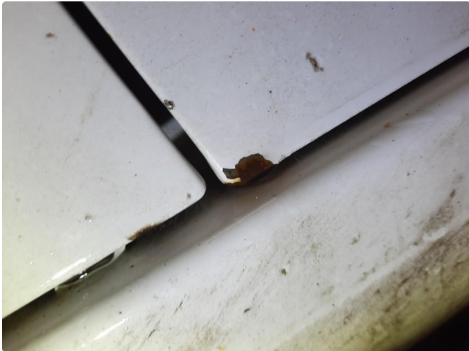
1.1 Rust/korrosjon
