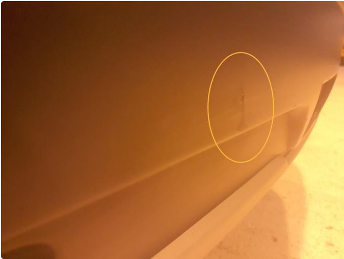
1.2 Noen riper ved dørterskel
