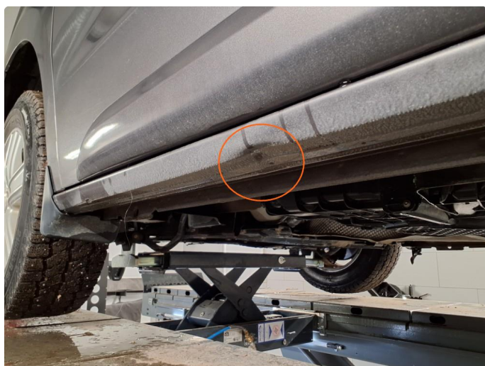
2.10 Bulk i kanal
