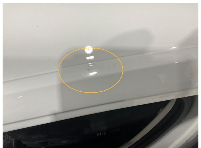
1.4 Ett steinsprang hvor det mangler lakk på stolpe over førerdør. Venstre foran.
