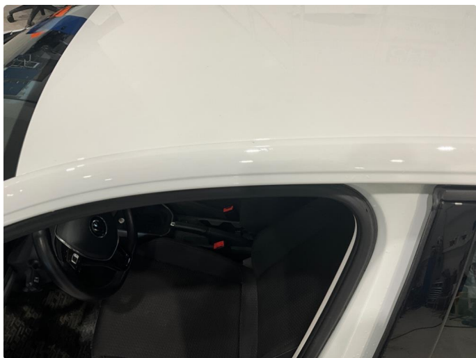
1.4 Ett steinsprang hvor det mangler lakk på stolpe over førerdør. Venstre foran.
