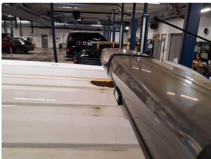
1.7 Rustflekker på tak.
