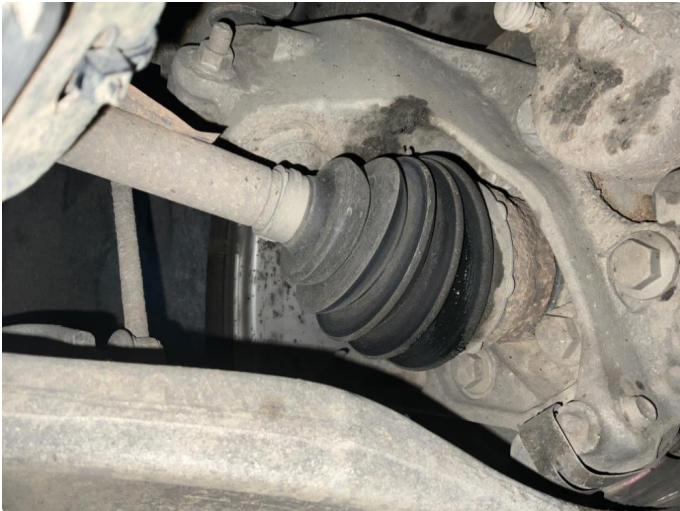
4.1 Defekt mansjett. Venstre Ytre Foran
