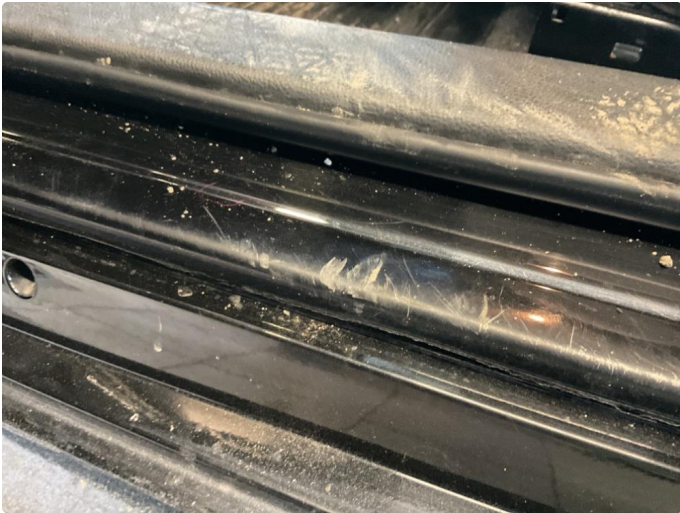
1.1 Slitt innsteg fører dør
