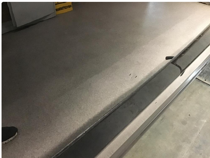
1.1 Bulk med lakkskade
