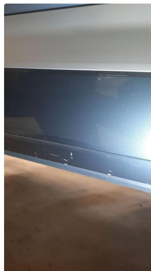
1.1 Ripe ned til grunning
