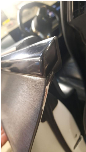
1.1 Ripe ned til grunning
