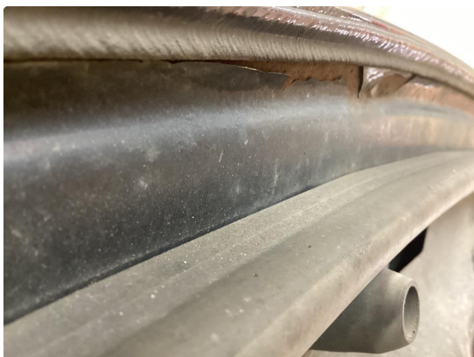
2.1 Rust i fals
