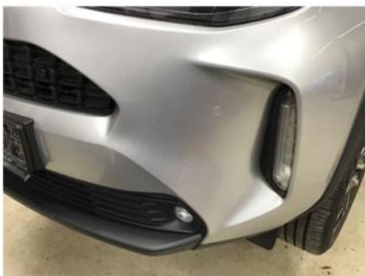
1.1 Noe steinsprutskader front.
